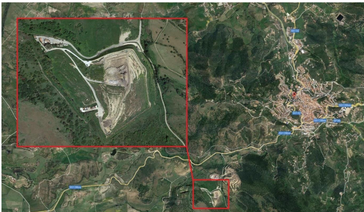
Figura 2: Foto satellitare area impianto (fonte Google Earth)
